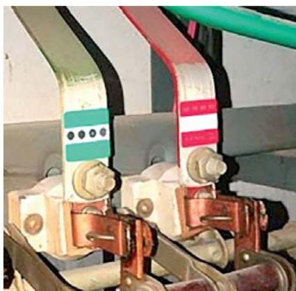
Рис. 2. Контактный термоиндикаторный контроль
