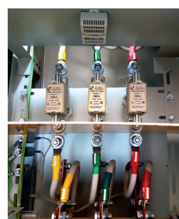
Пример расположения ТГН и ВГС в секции ВРУ
