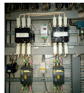
Пример расположения СГД и ТГН в шкафу ШАОТ
