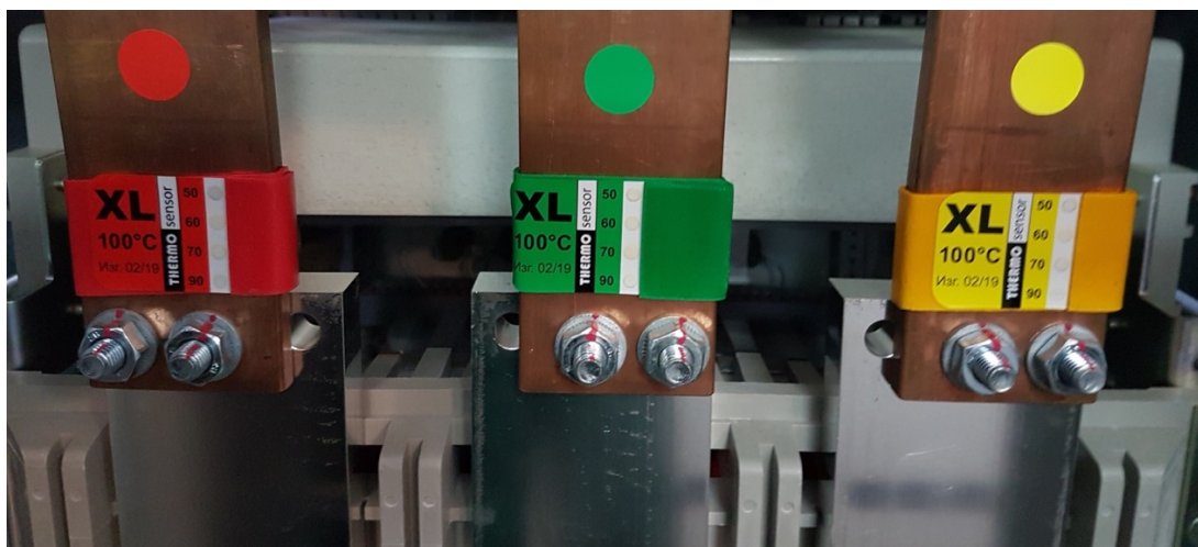
Рис. 6. Примеры размещения ТГН на контролируемых узлах
