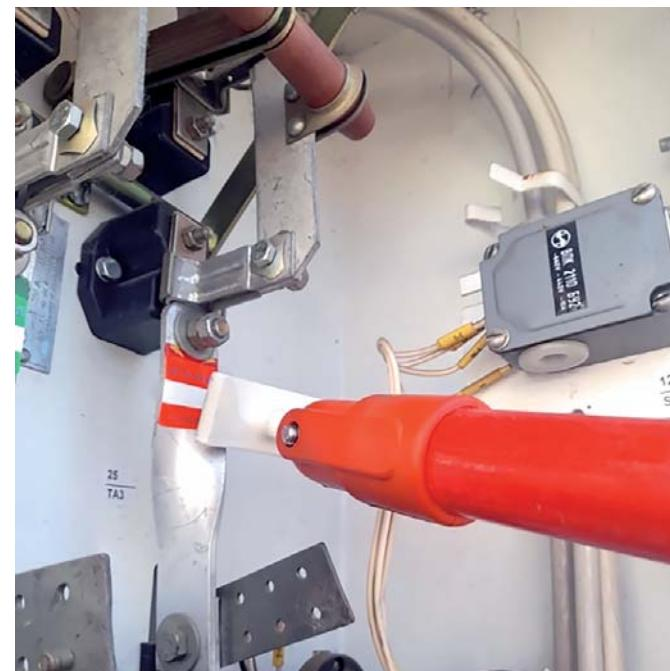
Рис. 9. Установка термоиндикаторов под напряжением
