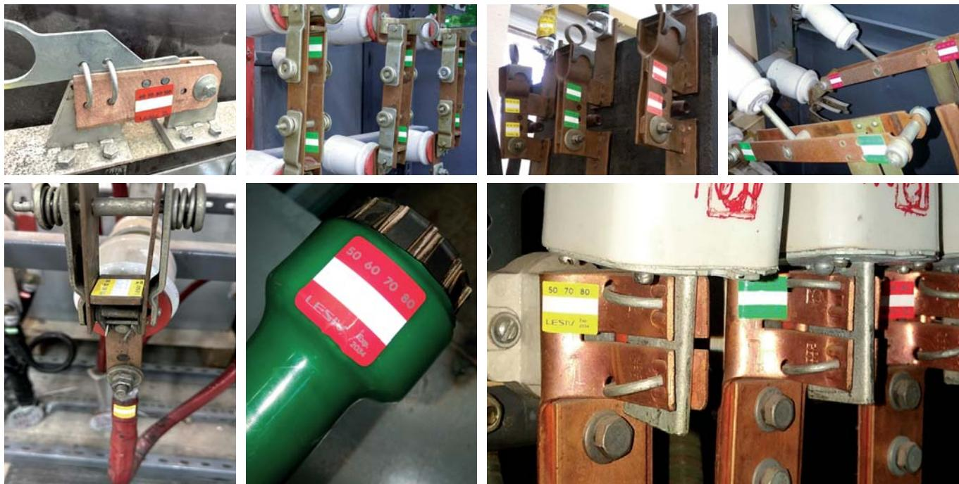
Рис. 7. Фотографии термоиндикаторов, установленных на контактах и контактных соединениях электрооборудования 0,4–10 кВ
