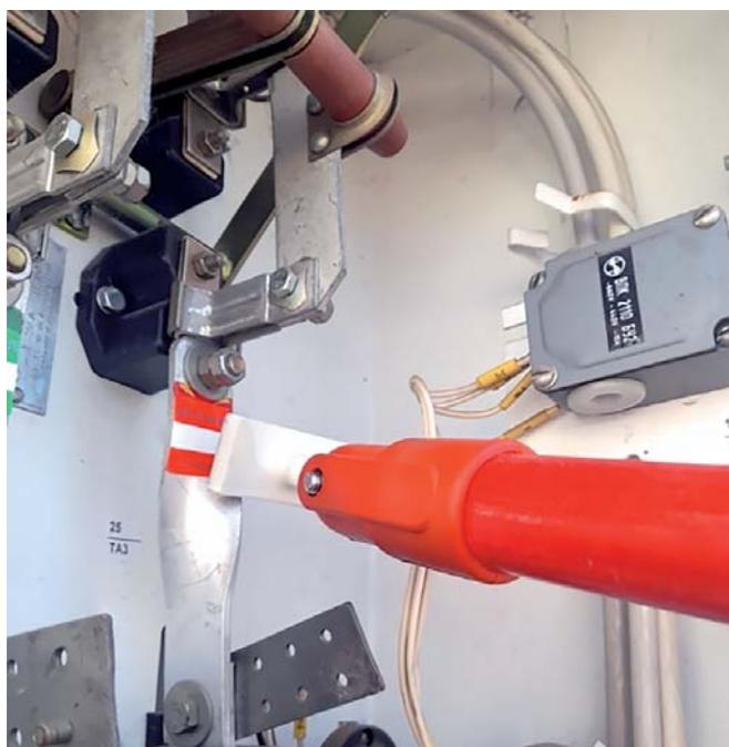
Рис. 9. Установка термоиндикаторов под напряжением
